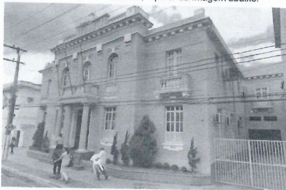
Imagem 02: Imagem cedida pelo sistema Google Street View, demonstrando que no ano de 2013, a fachada externa era exatamente a pintura atual.
