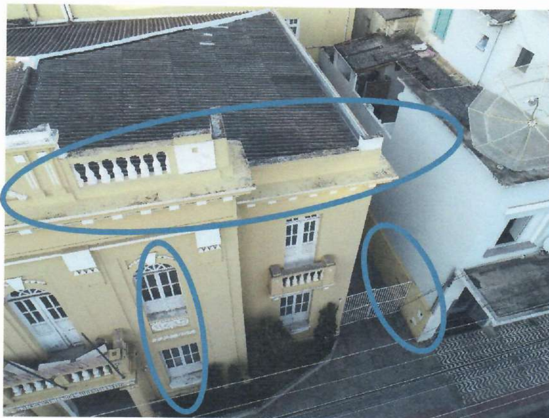
Imagem 04: Os círculos em azul demonstram a heregeneidade do reboco e demais falhas.
